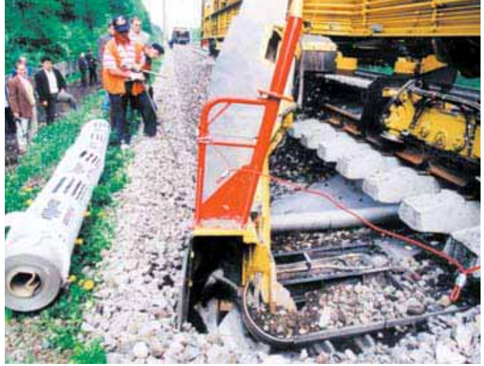
TCDD Demiryolu yenileme projesi
